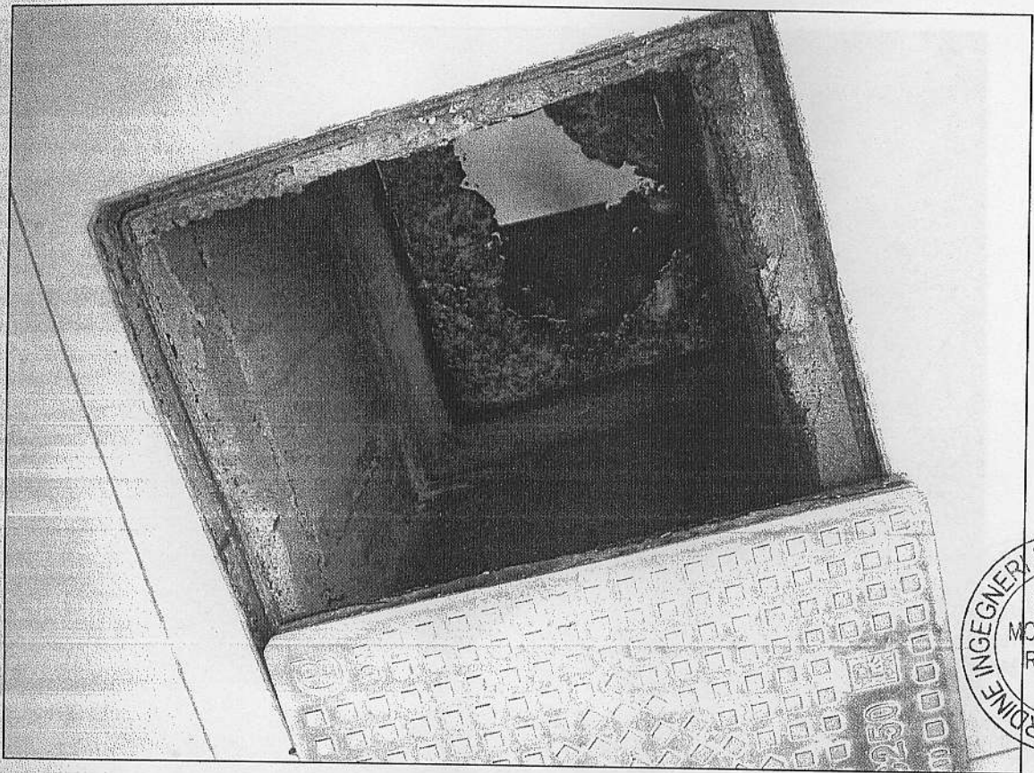
Foto n. 3: Pozzetto di ispezione della rete fognaria acque nere, localizzato in posizione equidistante tra la villetta n. 3 e l'angolo sud-est della palazzina
